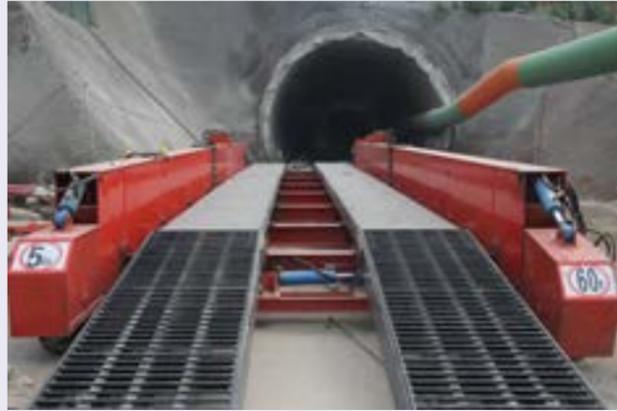
自行式仰拱栈桥施工明洞仰拱
