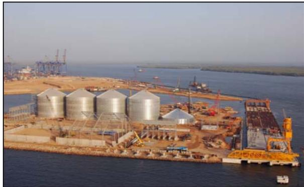
7个月日以继夜的辛勤劳作，于2010年3月16日顺利完成最后一根PHC桩施工，标志着FAP粮食化肥码头最重要最关键技术难度最大的大直径筒仓基础节点胜利完成，向业主交了一份完美的答卷。
